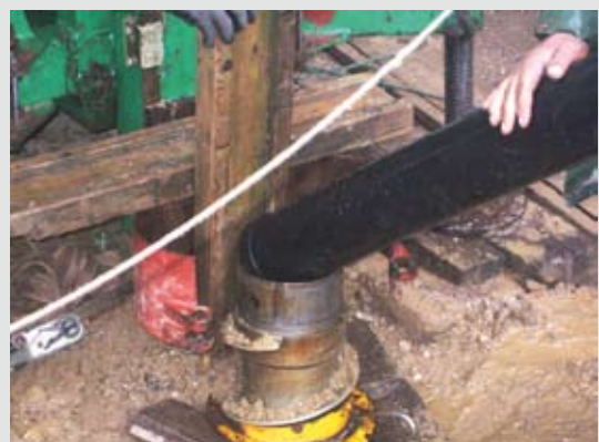
Die Sonde wird ins Erdreich geteuft
