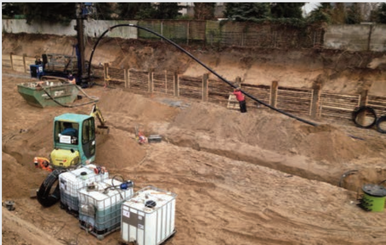
Teufen der geoKOAX-Sonden unter dem Gebäudekomplex
